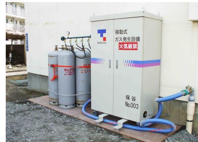
▲東日本大震災後、石巻市内の県営住宅に設置された移動式ガス発生設備(30㎡タイプ)<sup>24</sup>
